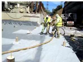
**Geomax Spray 200** es un tejido no tejido de fibras de polipropileno punzonado por una cara y calandrado termicamente por la otra. Este tejido exhibe una alta resistencia mecánica y ha sido diseñado como soporte para aplicaciones de Poliurea Rayston, formando un composite impermeabilizante de alta resistencia. En color negro turmalita para facilitar el control de la aplicación del producto proyectado. Disponible en versiones adhesiva y no adhesiva.
